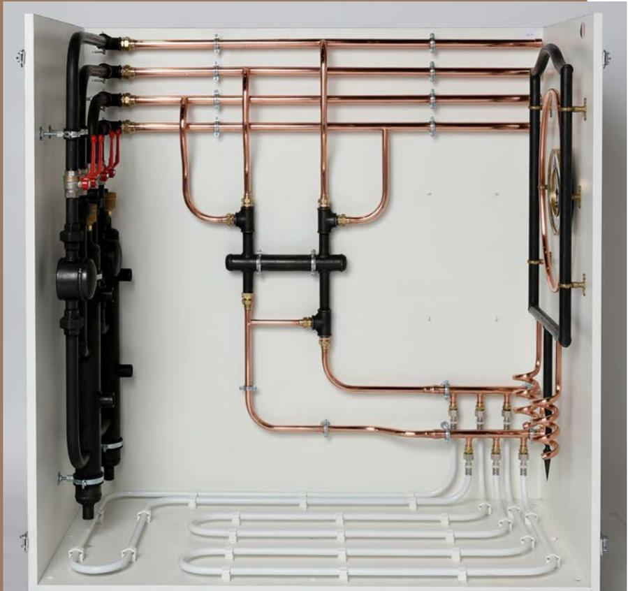
*Réalisation d'une partie d'installation à eau chaude et eau glacée avec plancher chauffant réversible rafraîchissant.*
